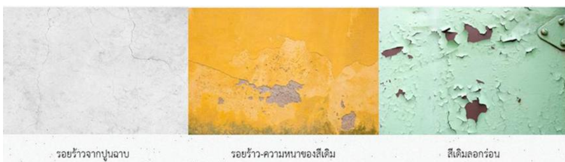
ภาพที่ 4.1 ตัวอย่างปัญหาที่ทำให้ต้องทำการปรับปรุงสภาพใหม่ กรณีผนังเดิมเป็นผนังฉาบปูนทาสี
