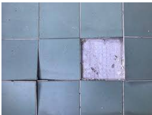
ภาพที่ 4.2 ตัวอย่างปัญหาที่ทำให้ต้องทำการปรับปรุงสภาพใหม่ กรณีผนังเดิมเป็นผนังกระเบื้องเซรามิก
