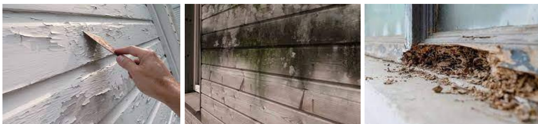
ภาพที่ 4.3 ตัวอย่างปัญหาที่ทำให้ต้องทำการปรับปรุงสภาพใหม่ กรณีผนังเดิมเป็นผนังไม้
