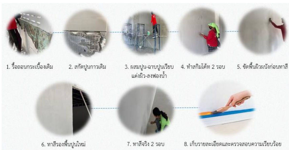
ภาพที่ 4.6 ขั้นตอนการดำเนินงานกรณีผนังเดิมเป็นผนังกระเบื้องเซรามิก ทำการปรับปรุงสภาพโดยการรื้อกระเบื้องเซรามิกเดิมออกและทาสีใหม่
